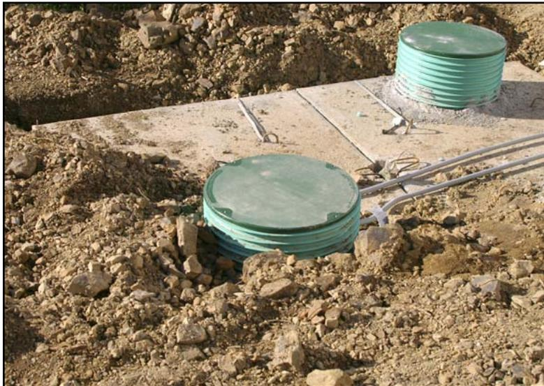
L'entretien d'une fosse septique doit être régulier afin d'éviter l'accumulation de déchets dans l'installation. Cela comprend la vidange et le curage de la fosse, ainsi que la maintenance des filtres plantés.
