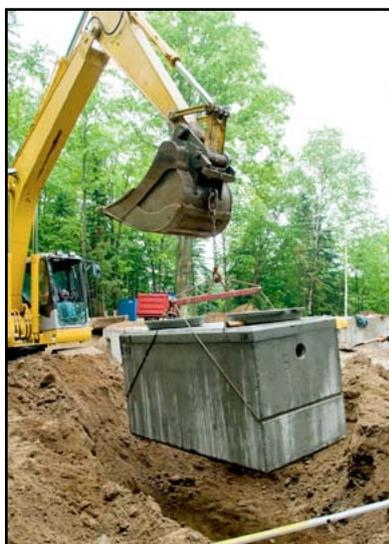
Le creusement de la fosse toutes eaux doit s'adapter au volume de l'installation et au type d'épuration choisi : tranchée d'épandage, filtre à sable.
